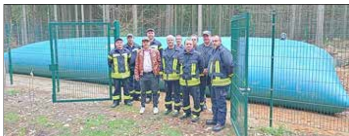
Löschwasserbehälter in Lückendorf am Forsthaus
