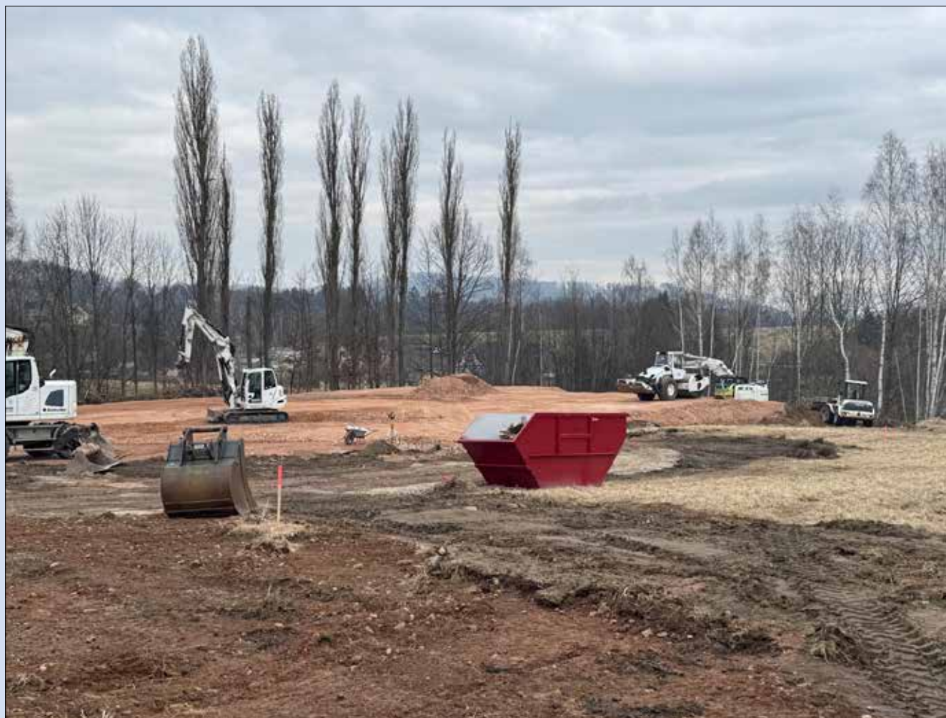
Die Bauarbeiten schreiten voran.
