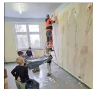
Während der Renovierung
